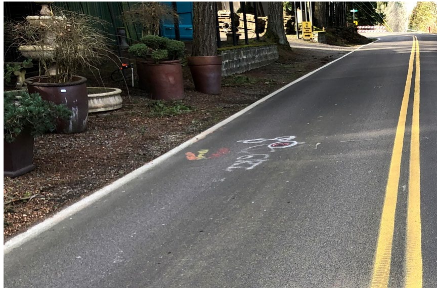
Core B-2 (SW Blake St., STA 17 + 72, FWD #15 NB)
